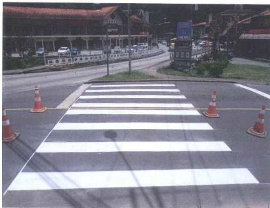
Figura 4-113 Rota 116 – Implantação Faixa de Pedestre – km 76,5
