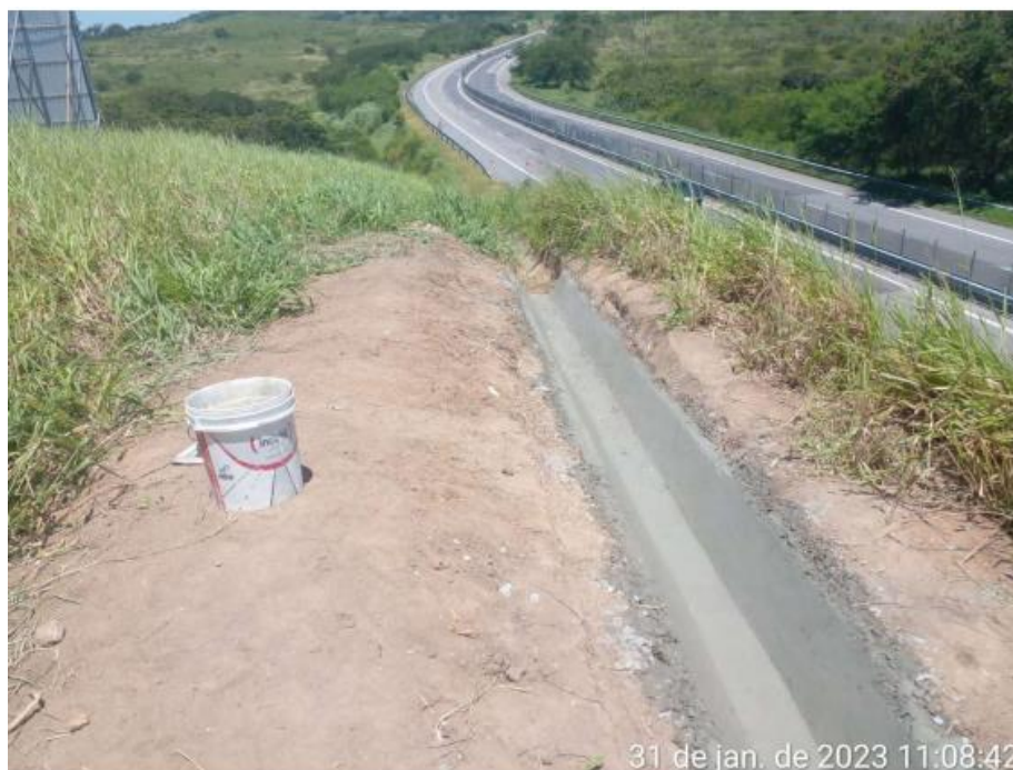
Figura 4-9 Via Lagos – Implantação Drenagem Superficial
