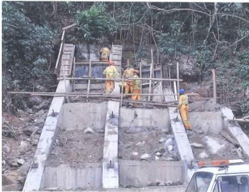
Figura 4.12 Rota 116 – Obra emergencial de contenção – km 44 .1
