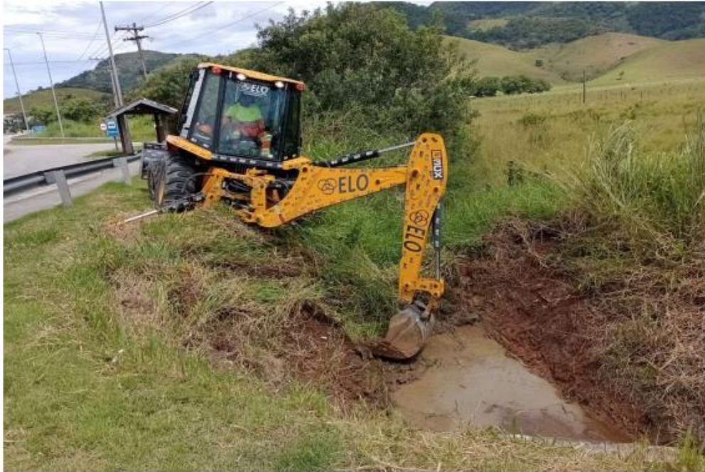
Figura 4-4 Via Lagos - Limpeza de Bueiro - Km 12+400 Norte
