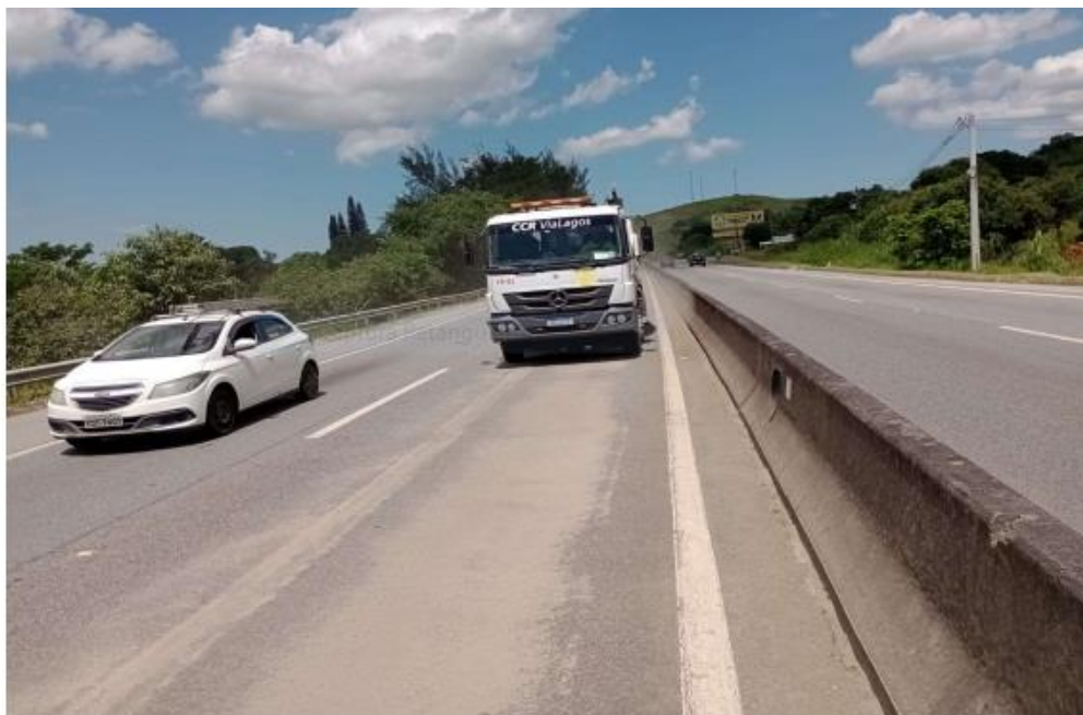
Figura 4-7 Via Lagos - Varrição de Mediana - Km 14+000 Sul
