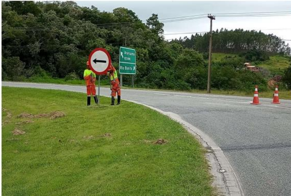
Figura 4-2 Via Lagos – Nivelamento de Placa - Km 21+500 Sul
