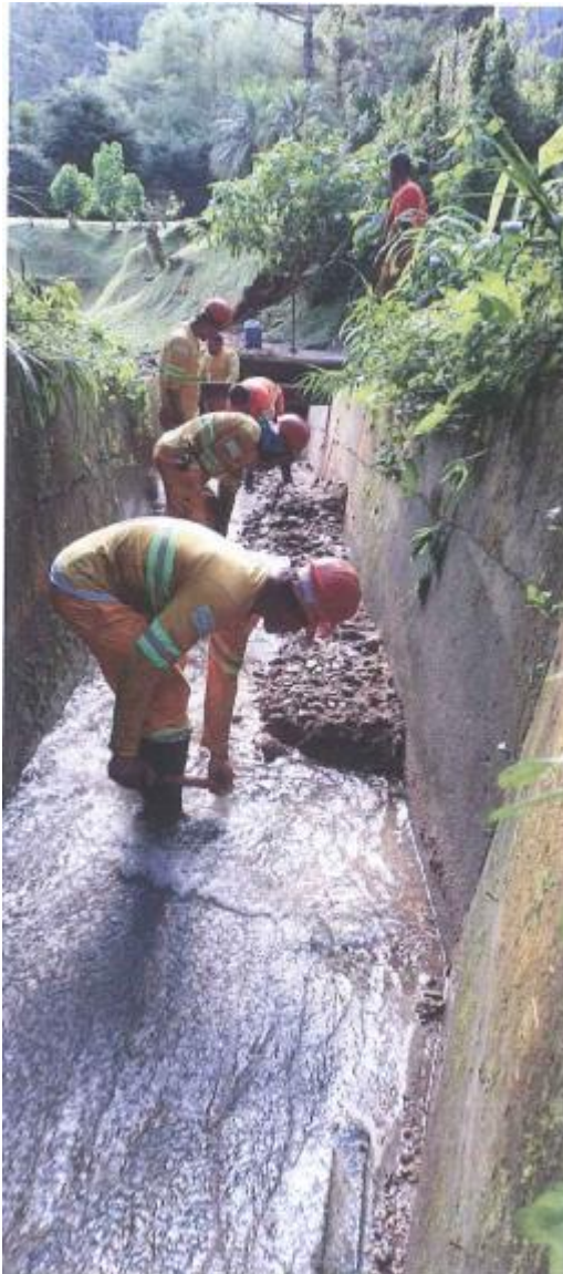
Figura 4.14 Rota 116 – Limpeza e Recuperação de drenagem – km 75
