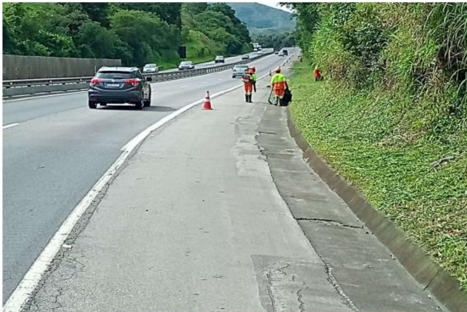
Figura 4-5 Via Lagos - Roçada Manual - Km 4+400 Norte
